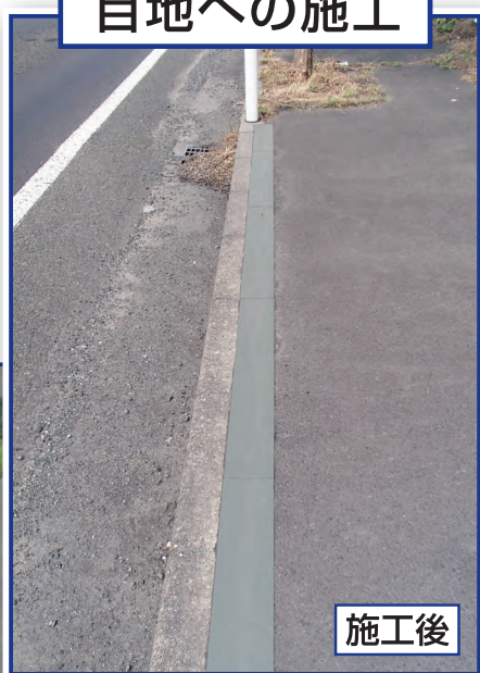
目地への施工
