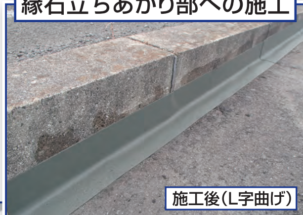
縁石立ちあがり部への施工
